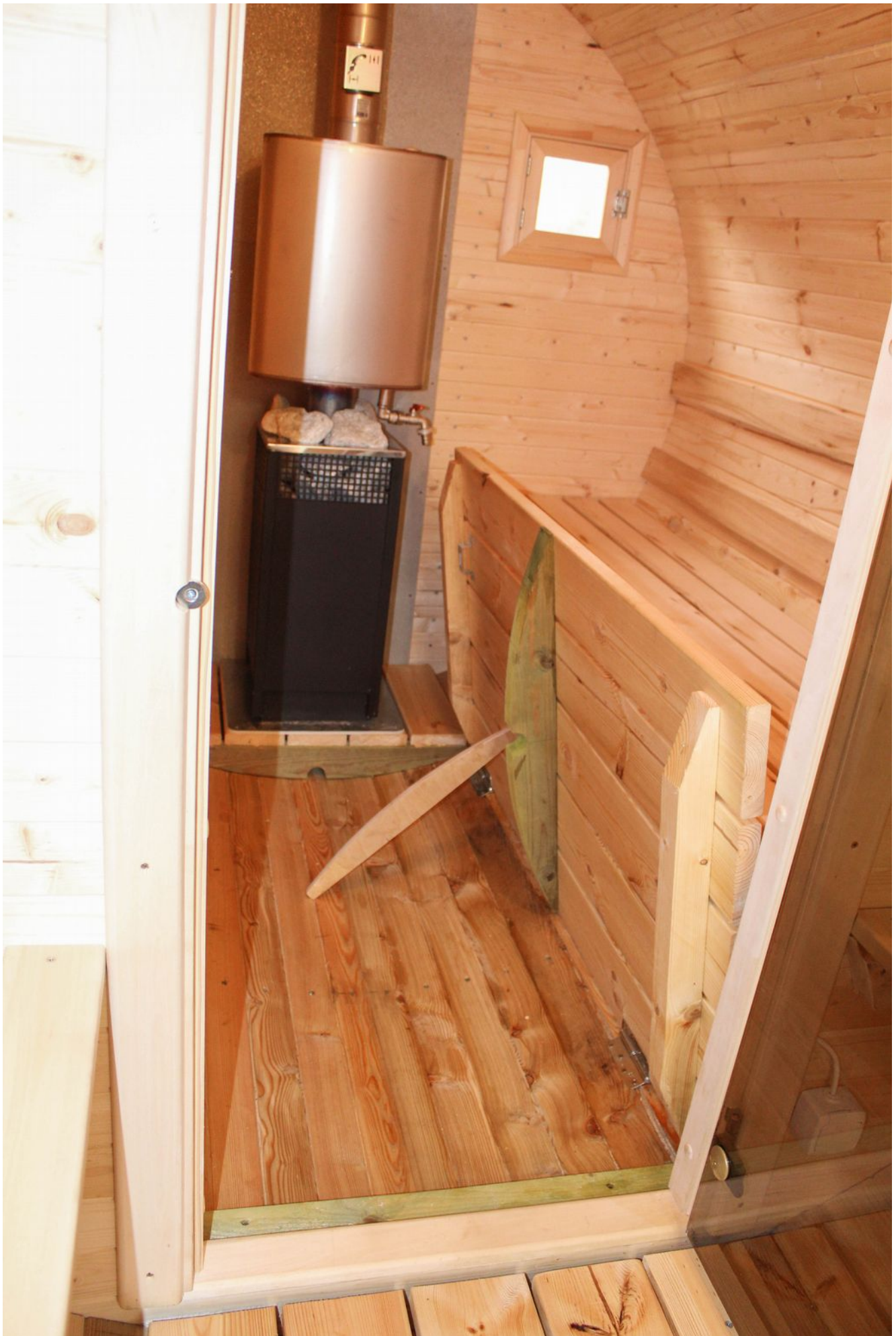
Фото№7. Откидной трапик.
